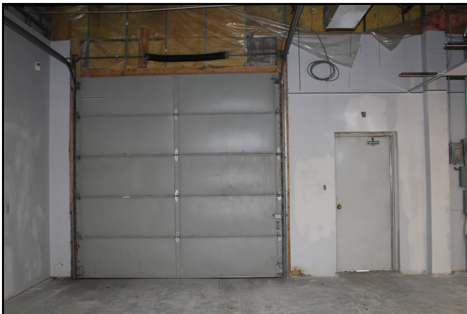
Above: Roll up door and man door
